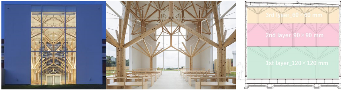
Şekil 12. Agri Chapel fraktal strüktüre sahip bir yapı (URL 11)
